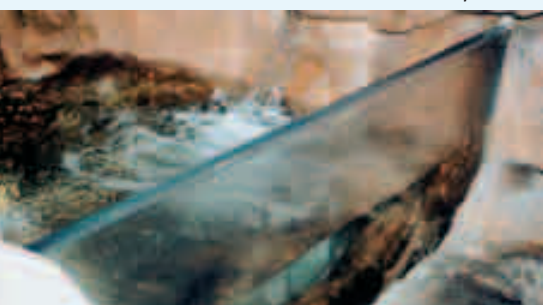
O acrílico resiste bem à pressão da água e aos choques com os animais
