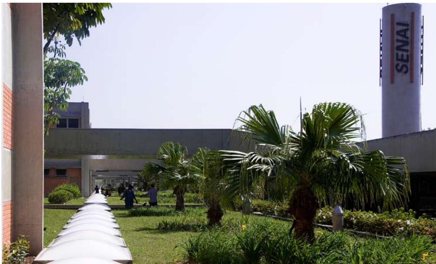
São mais de 20 anos de instalação dos 150 domos na Escola Senai Mario Amato. Acima, exemplo de aplicação em estrutura residencial
