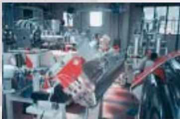
Máquina extrusora instalada na unidade tem capacidade para 5 mil t anuais
